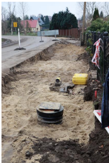
Budowa sieci kanalizacyjnej Charbrowo – Wicko
